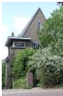
Rechts: Rivierdijk 579, een van de door M.C. Donk ontworpen woonhuizen.
