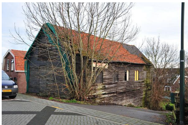
Mooi zo'n door gebrek aan onderhoud verweerde schuur.
