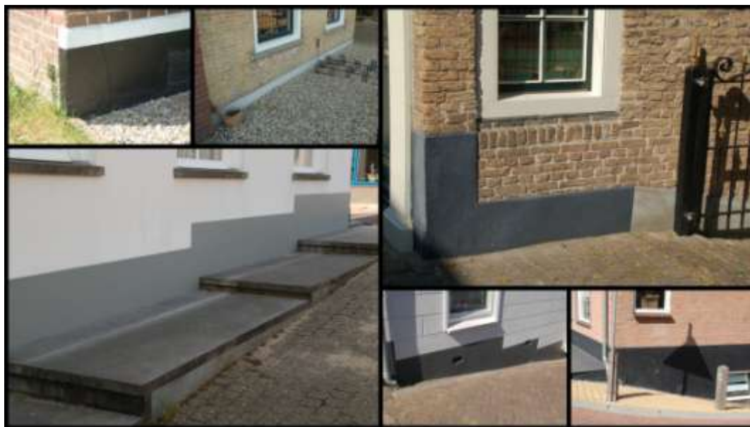
Voorbeelden van eenvoudige waterkeringen in ons dorp. Soms fraai aangepast aan het verschil in dijkniveau.
