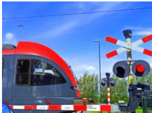
Andreaskruis bij de spoorwegovergang naar de Neerpolderseweg
