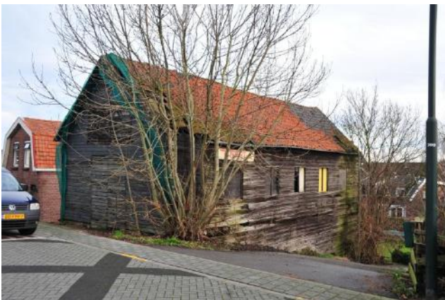
De oude loods van Dimaha aan de Rivierdijk.
