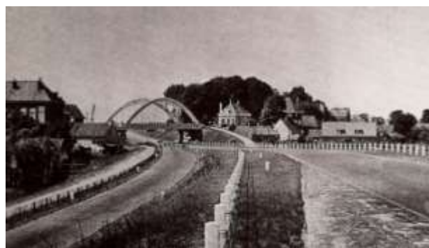
Zicht op de witte boogbrug en Meijwaardstoep vanaf de rijksweg.
