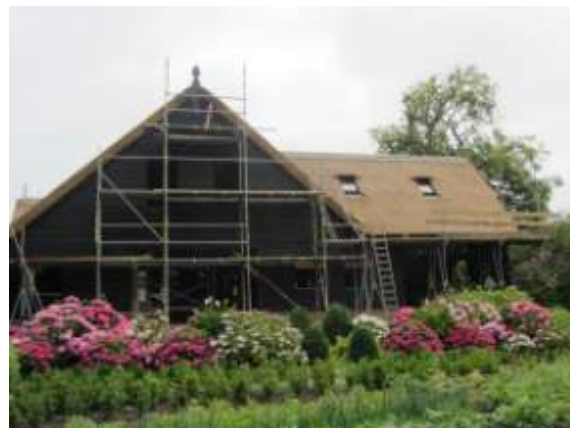
Het rieten dak is klaar
